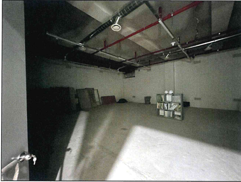
[ 일련번호(1) 내부 전경 ]
