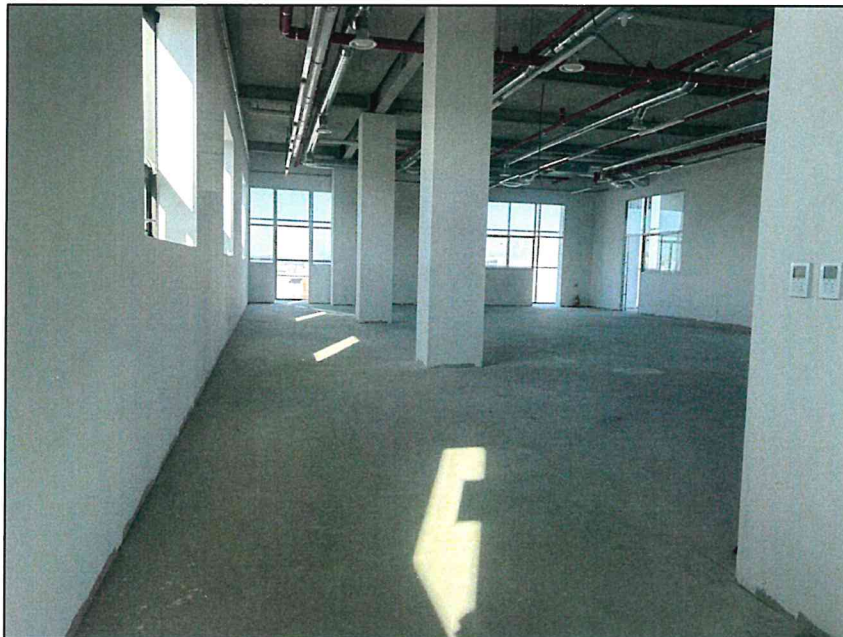
[ 일련번호(5) 내부 전경 ]
